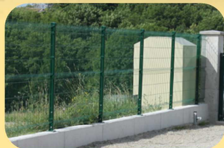
Réfection de clôture de la cours de récréation
